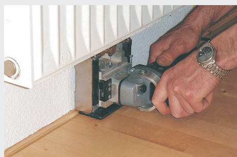
Řezání dilatačních spár pod radiátory
